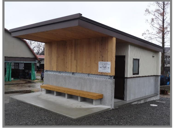
屋外トイレ (真庭市内)
