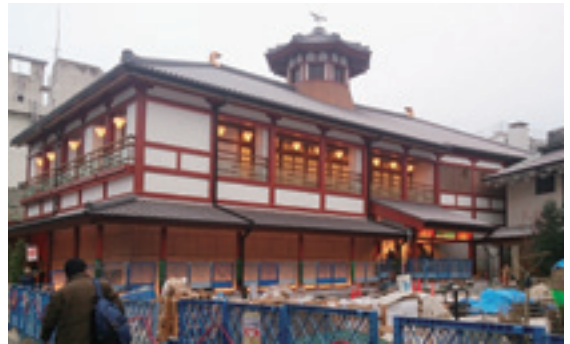
図5 中庭が工事中の飛鳥乃湯泉 外観
